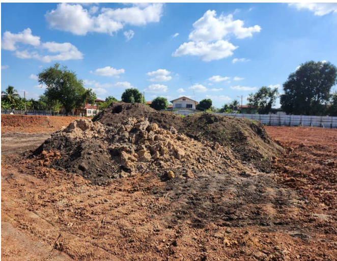
ภาพที่ 2.2-7: การแยกหน้าดินเพื่อใช้สำหรับปลูกต้นไม้
