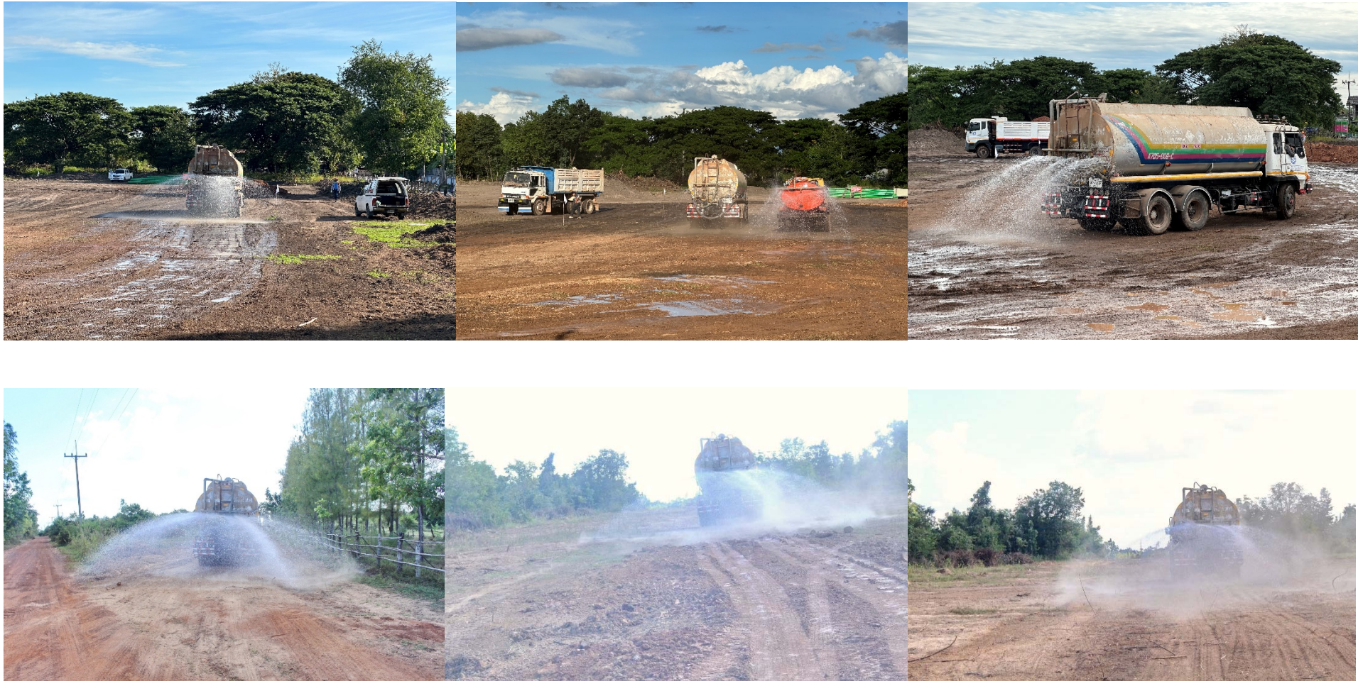
ภาพที่ 2.2-9 : การฉีดพ่นน้ำเพื่อลดฝุ่นละอองในพื้นที่ที่มีการเปิดหน้าดินของโครงการฯ
